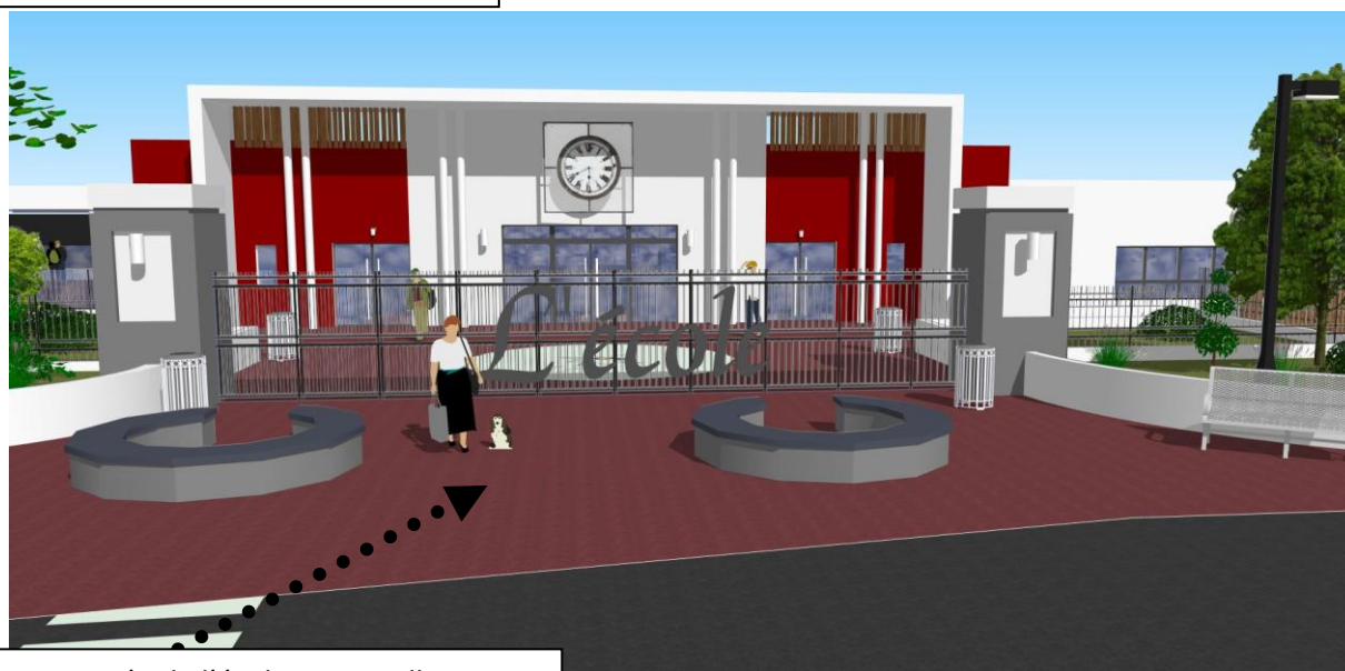
Entrée de l'école maternelle et élémentaire – vue du dépose minute
